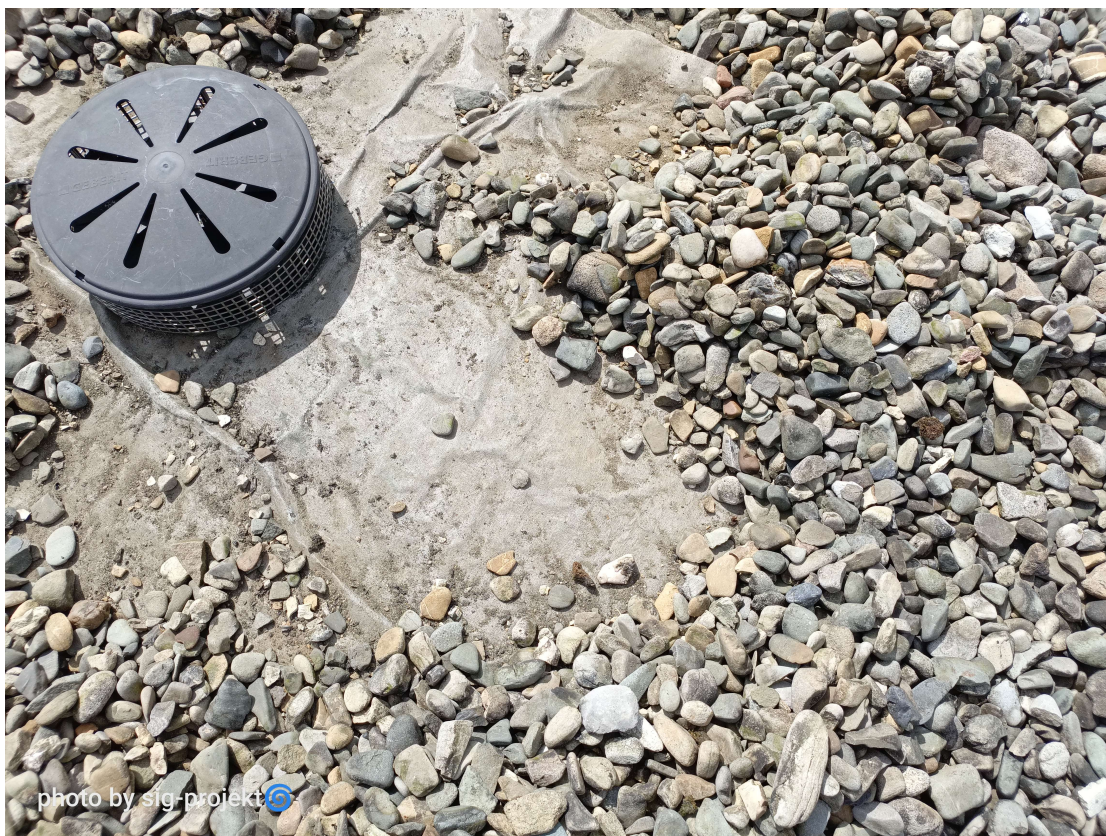
Zdj. nr 1 – po ściągnięciu balastu widoczne niecka wokół wpustu
