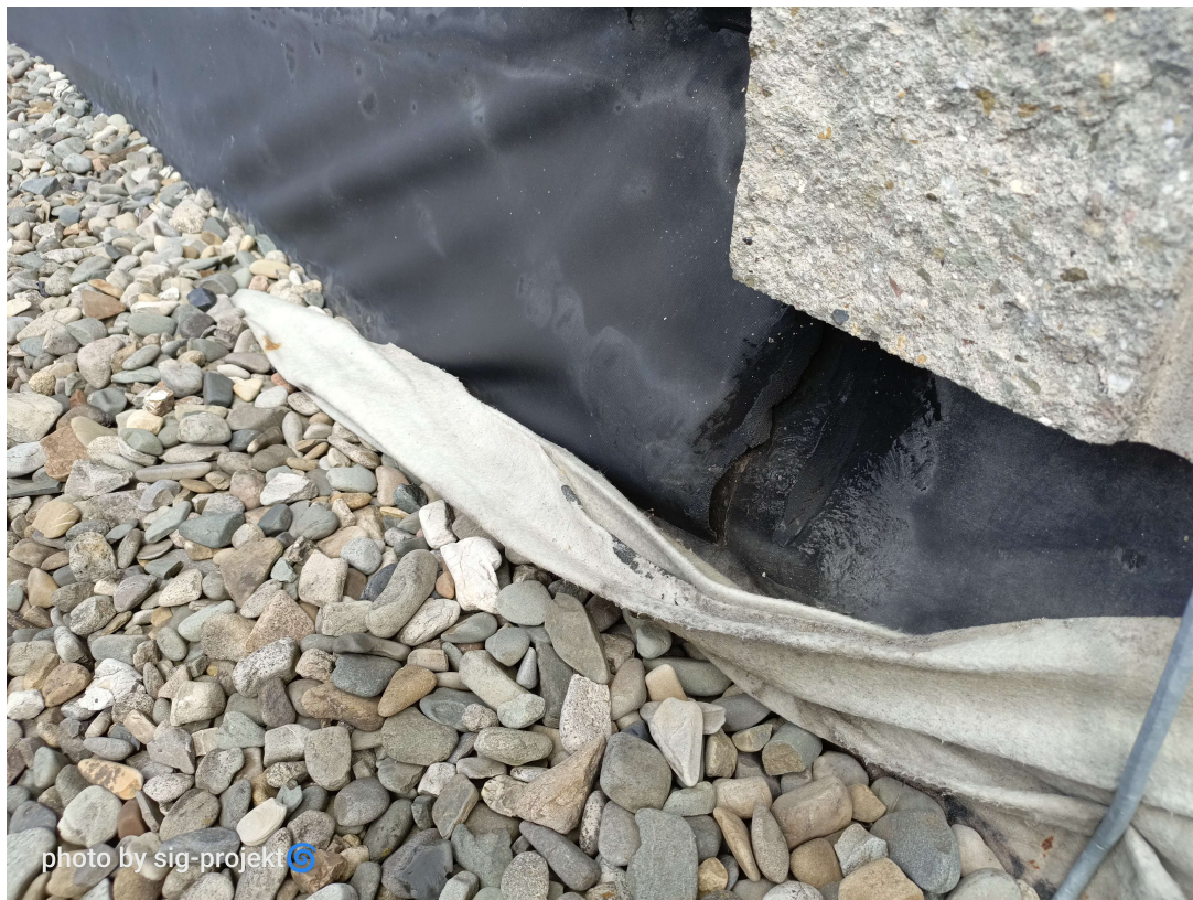
Zdj. nr 3 – kolejne uszkodzenia membrany na elementach pionowych
